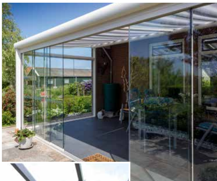
▼ Véranda neuve - Merzig - Allemagne
