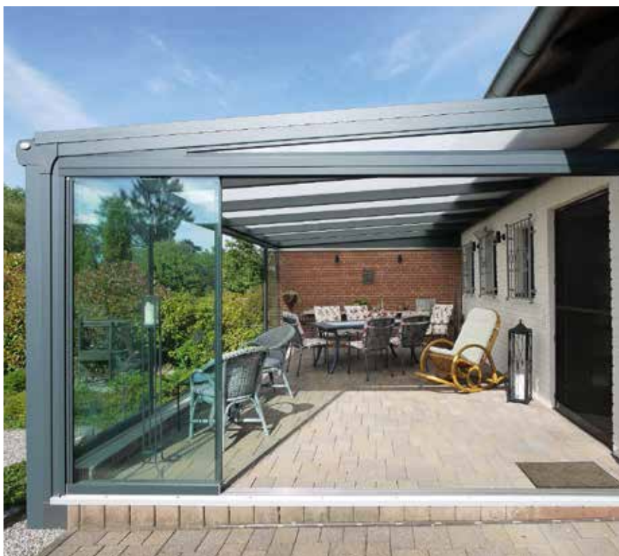
▲ Rénovation avec Climax® Panorama - Krefeld - Allemagne
