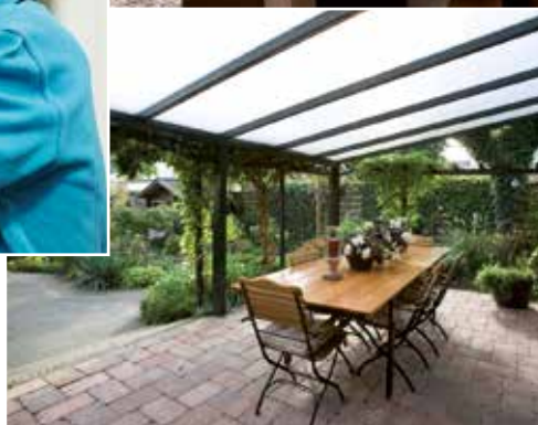
▲ Recouvrement de terrasse avec Climax® - Zeeland - NI
